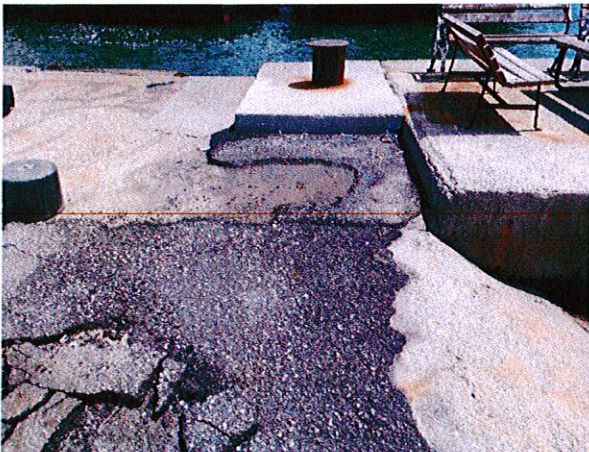
Resim 3.1. Tahrip olmuş asfalt zemin ve tadilat yapılacak alanını gösterir resim
