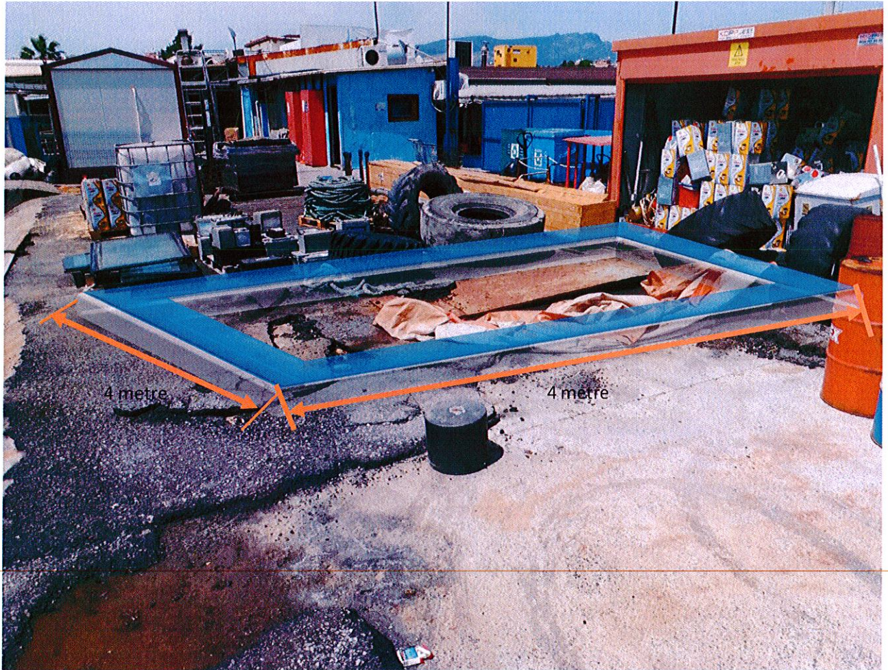
Resim 3.2. Yapılacak taşıntı havuzunu ve yaklaşık ölçülerinin gösterir resim
